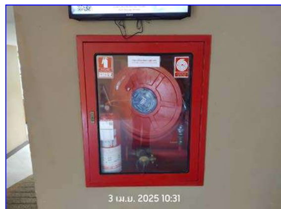
รูปที่ 2.16 ถังดับเพลิงและตู้เก็บสายฉีดน้ำดับเพลิง
