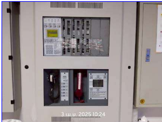
รูปที่ 2.20 แผงควบคุมระบบสัญญาณแจ้งเหตุเพลิงไหม้
