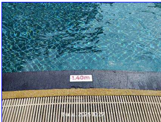
รูปที่ 2.24 ป้ายแสดงระดับความลึก และรางระบายน้ำ
