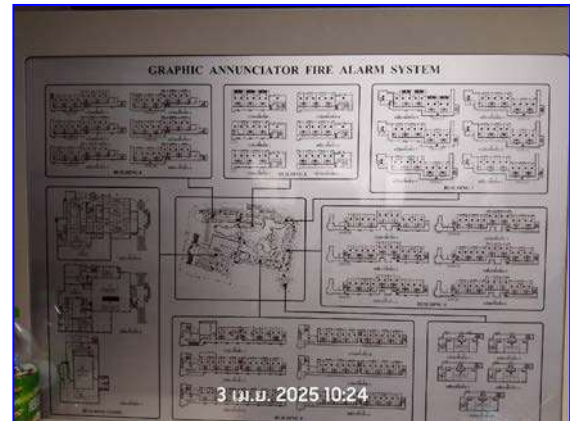
รูปที่ 2.20 แผงควบคุมระบบสัญญาณแจ้งเหตุเพลิงไหม้
