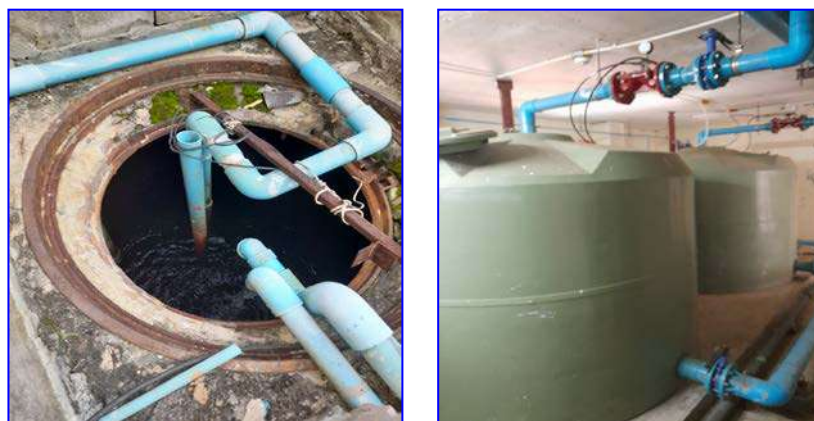
รูปที่ 2.7 ถังเก็บน้ำสำรองชั้นใต้ดิน และชั้นดาดฟ้า
