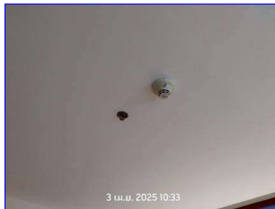
รูปที่ 2.15 อุปกรณ์ตรวจจับควัน และสปริงเกอร์ดับเพลิง
